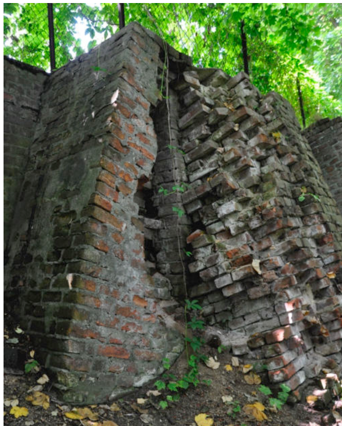
Ryc. 88: Relikty muru; widoczne znaczne uszkodzenia (zawilgocenie, zasolenie oraz znaczne ubytki struktury) narożnika muru oraz przypór – dostawionych wtórn timer (widoczny brak powiazania muru oraz inny rodzaj użytej cegły); / fotografia ACAKA 2023
