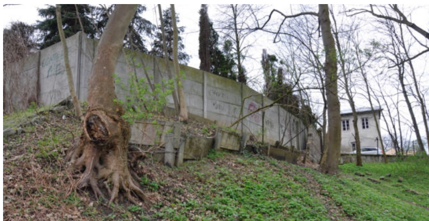
Ryc. 81: ogrodzenie z betonowych elementów prefabrykowanych – od strony terenu Sądu Rejonowego / fotografia ACAKA 2022
