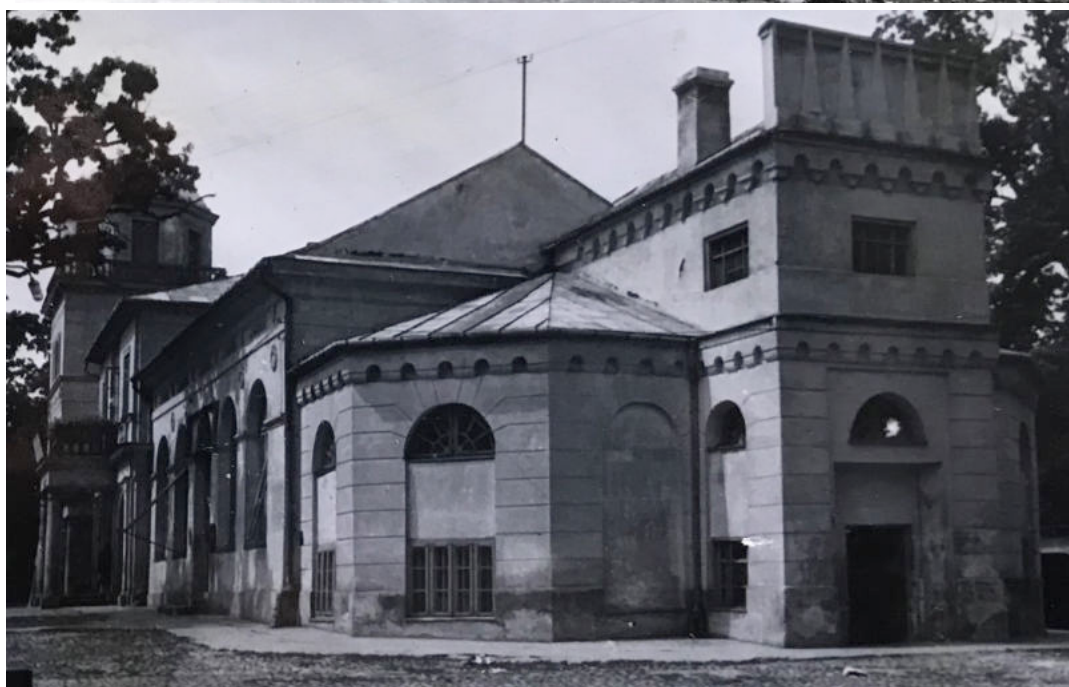
Ryc. 21: pałac Ostrowskich w Tomaszowie Mazowieckim w 1957, elewacja wschodnia, od strony podwórza gospodarczego / fotografia z Archiwum NID, teki prof. Gerarda Ciołka
