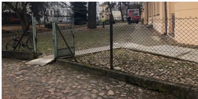
Ryc. 60: ogrodzenie oddzielające teren wokół pałacu – muzeum od części gospodarczej – aktualnie parkingu / fotografia ACAKA 2022
