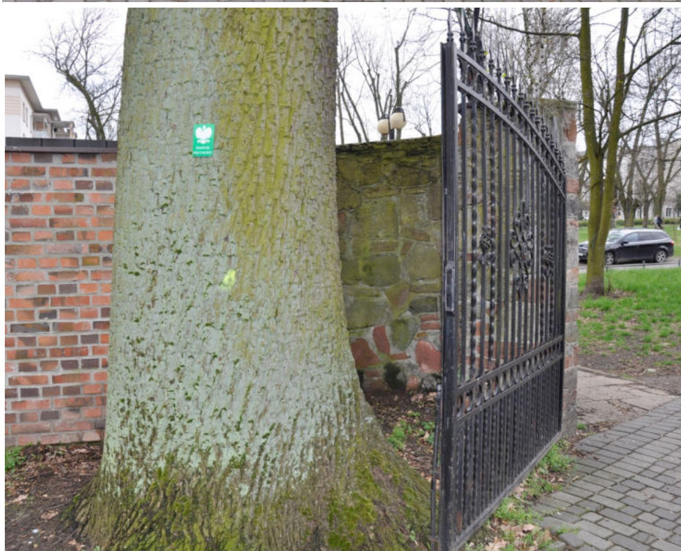
Ryc. 91: prawe skrzydło bramy – widok od strony parku, widoczne drzewo pomnikowe rosnące bezpośrednio przy bramie oraz fragment muru z kamienia naturalnego lokalnego przeznaczony do konserwacji. / fotografia ACAKA 2023
