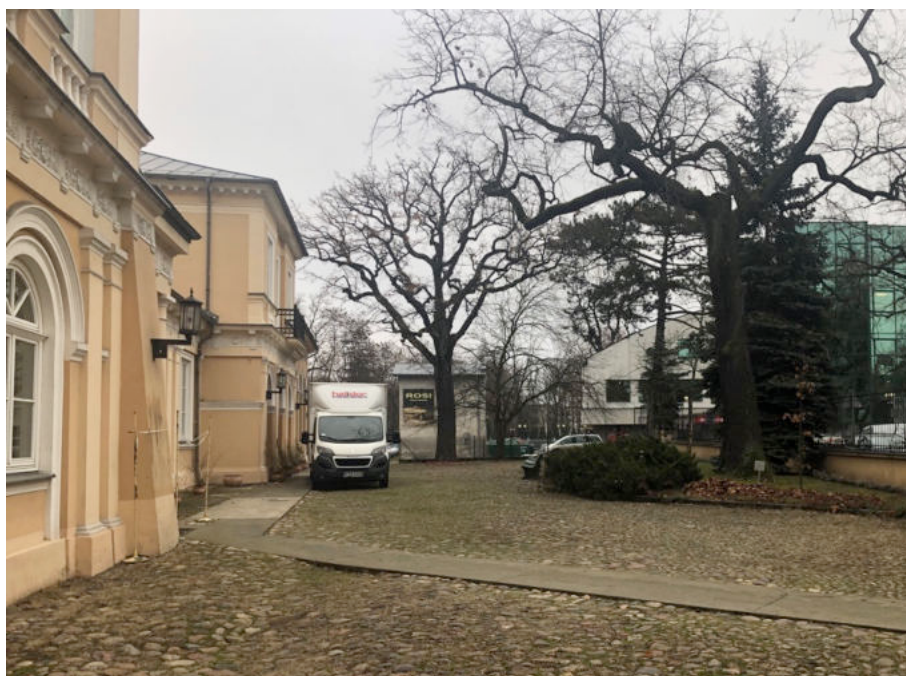
Ryc. 53: przestrzeń przed elewacją południową pałacu / muzeum – od frontu, od strony ulicy POW – widok od zachodu / fotografia ACAKA 2022
