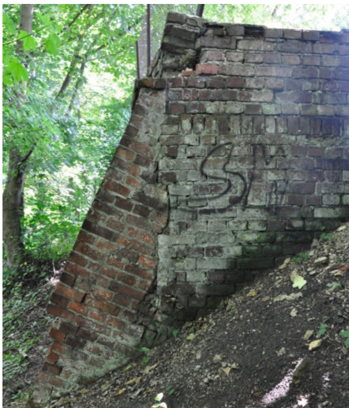
Ryc. 89: Relikty muru; na fotografii widoczny brak wiązania wtku ceglanego pomiędzy murem dawnej piwnicy a przyporą dostawioną najpewniej wtórn timer ze względu na utratę nośności ściany. / fotografia ACAKA 2023
