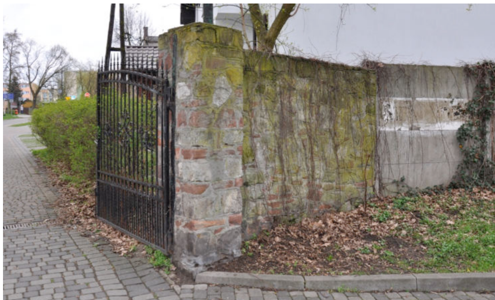
Ryc. 90: lewe skrzydło bramy – widok od strony parku; widoczny fragment muru z kamienia naturalnego lokalnego przeznaczony do konserwacji. / fotografia ACAKA 2023.
