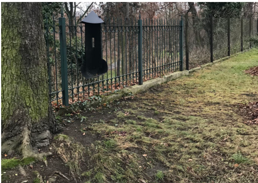
Ryc. 1: ogrodzenie na krawędzi skarpy pomiędzy częścią parku związaną bezpośrednio z pałacem a parkiem – widoczna część wykonana z giętych prętów oraz kontynuacja ze stalowej siatki / fotografia ACAKA 2022
