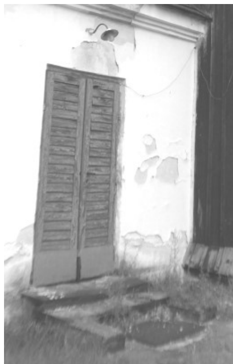
fot. 12. Widok tylnej i przedniej strony drzwi opierzonych, z nawierzchniowym kowalskim zamkiem skrzynkowym, z poziomymi klepkami deskowymi, prowadzące z kruchty głównej na zewnątrz
