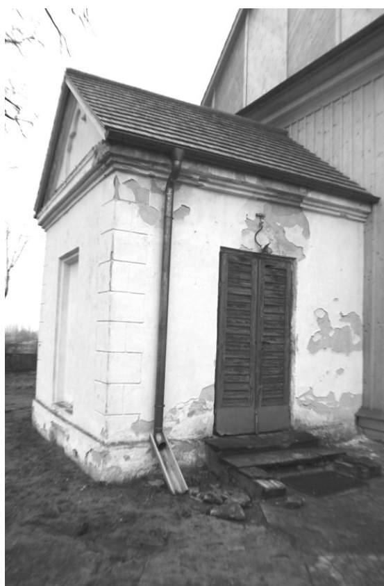
fot. 17. Widok zawilgocenia oraz wysoleń na powierzchniach murów oraz degradacji tynków kruchty głównej
