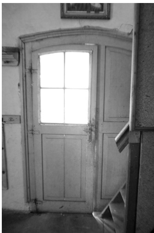
fot. 13. Widok dwuskrzydłowych, wewnętrznych drzwi płycinowych z zamkiem wpuszczanym, prowadzących z zakrystii na zewnątrz
