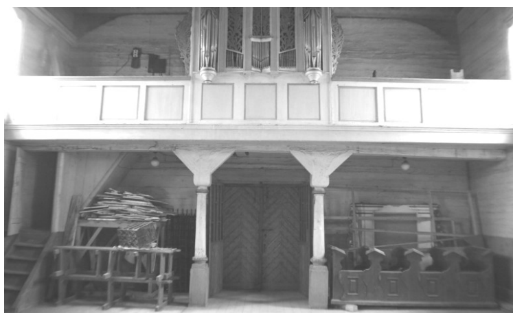
fot. 9. Widok chóru z obniżeniem podparcia belki głównej z prawej strony – od zachodu
