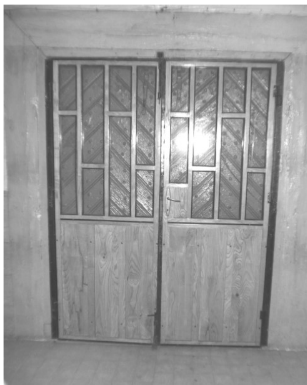
fot. 11. Widok przedniej strony drzwi opierzonych z klepkami deskowymi układanymi w jodełkę z nabitymi gwoździami kowalskimi z ozdobnymi główkami oraz współczesnych drzwi ramowych przeznaczonych do demontażu pomiędzy nawą a kruchtą główną
