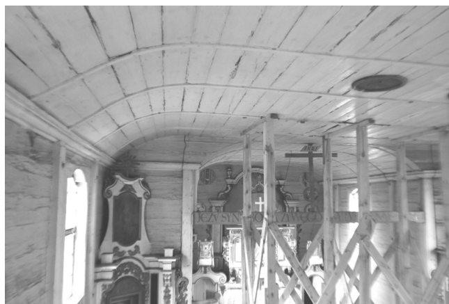
fot. 8. Widok łukowo profilowanego deskowania sklepienia wraz z gzymsowaniem w nawie – w trakcie remontu kościoła w 2014 r
