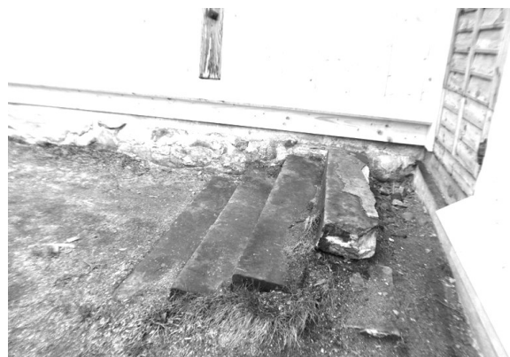
fot. 17. Widok zniszczonych pozostałości kamiennych schodów zewnętrznych przy kruchcie głównej i kruchcie bocznej
