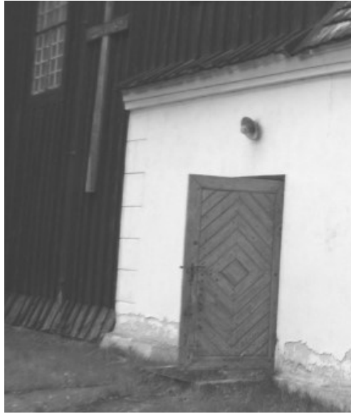
fot. 14. Widok przedniej strony drzwi opierzonych z klepkami deskowymi układanymi w romby prowadzącymi na zewnątrz zakrystii
