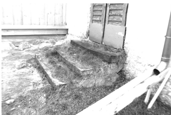
fot. 17. Widok zniszczonych pozostałości kamiennych schodów zewnętrznych przy kruchcie głównej i kruchcie bocznej
