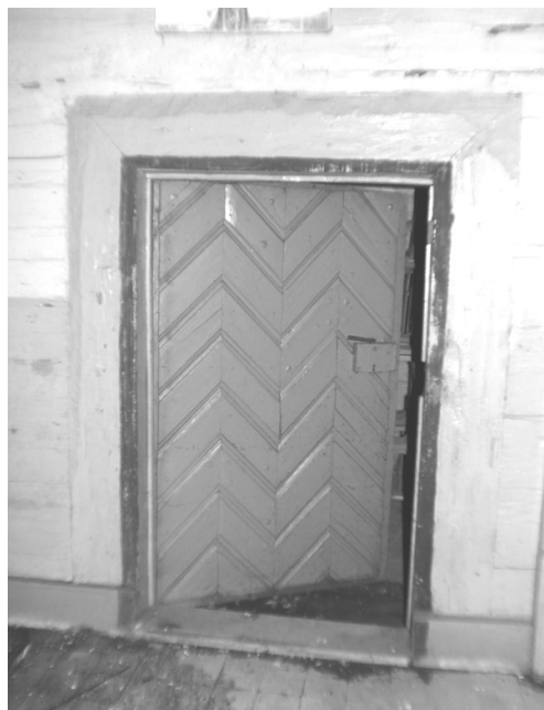
fot. 15. Widok przedniej strony drzwi opierzonych z klepkami deskowymi układanymi w jodełkę z nawierzchniowym kowalskim zamkiem skrzynkowym pomiędzy nawą a kruchtą boczną
