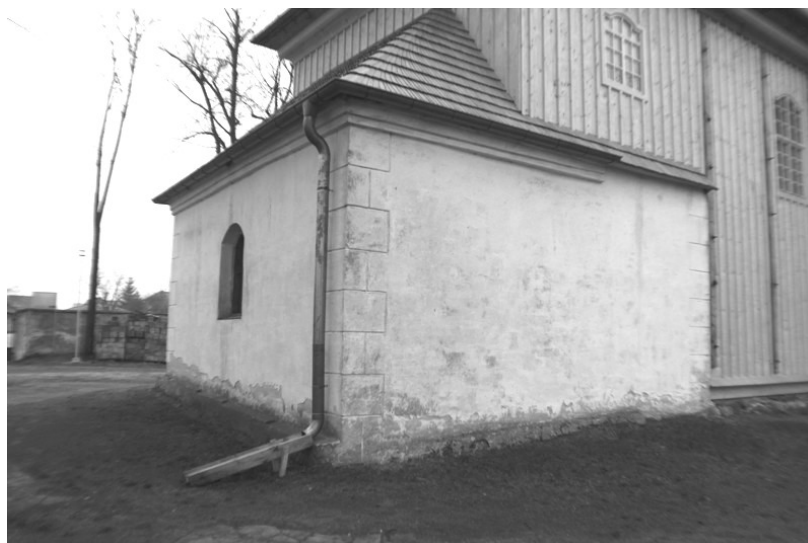
fot. 16. Widok zawilgocenia oraz degradacji tynków dolnej części murów zakrystii
