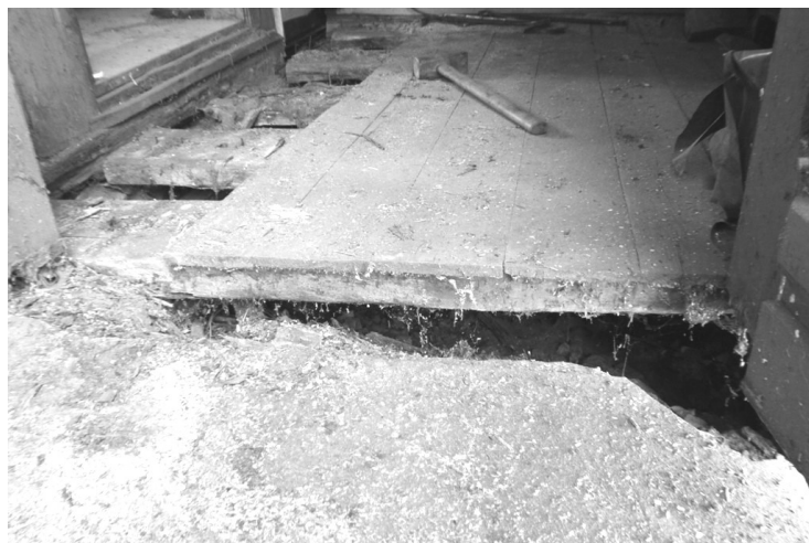
fot. 6. Widok złego stanu technicznego podłogi w kruchcie bocznej
