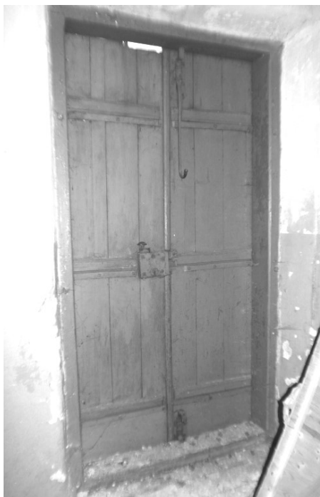
fot. 12. Widok tylnej i przedniej strony drzwi opierzonych, z nawierzchniowym kowalskim zamkiem skrzynkowym, z poziomymi klepkami deskowymi, prowadzące z kruchty głównej na zewnątrz
