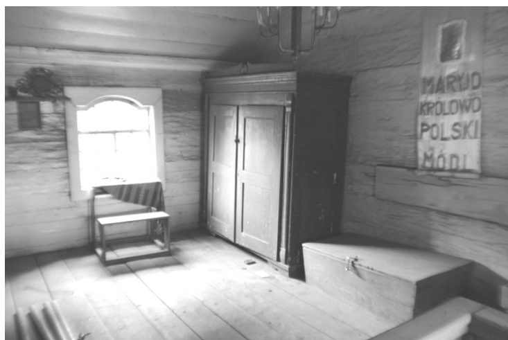
fot. 7. Widok drewnianej podłogi oraz ścian i łukowo profilowanego sklepienia z gzymsowaniem w górnej kaplicy nad zakrystią
