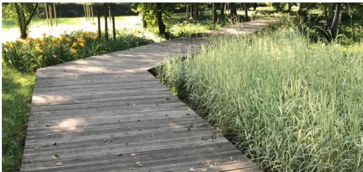
Ryc. 4: przykład podobnej realizacji – aleje piesze z elementów drewnianych montowane nieco ponad poziomem terenu ze względu na jego podmokły charakter (Grodzisk Mazowiecki, park nad rzeką Mrowną, projekt ACAKA 2017)
