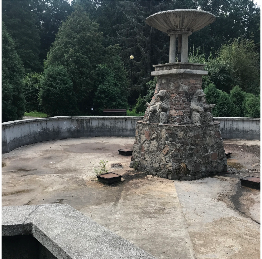
Ryc. 10: trzon fontanny z łączonych za pomocą zaprawy elementów kamiennych z rzeźbami niedźwiedzi / fotografia ACAKA 2022
