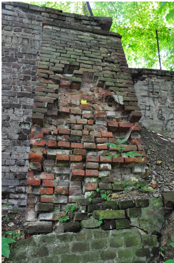
Ryc. 88: Relikty muru; widoczne znaczne uszkodzenia (zawilgocenie, zasolenie oraz znaczne ubytki struktury) narożnika muru oraz przypór – dostawionych wtórnie (widoczny brak powiązania muru oraz inny rodzaj użytej cegły); / fotografia ACAKA 2023
