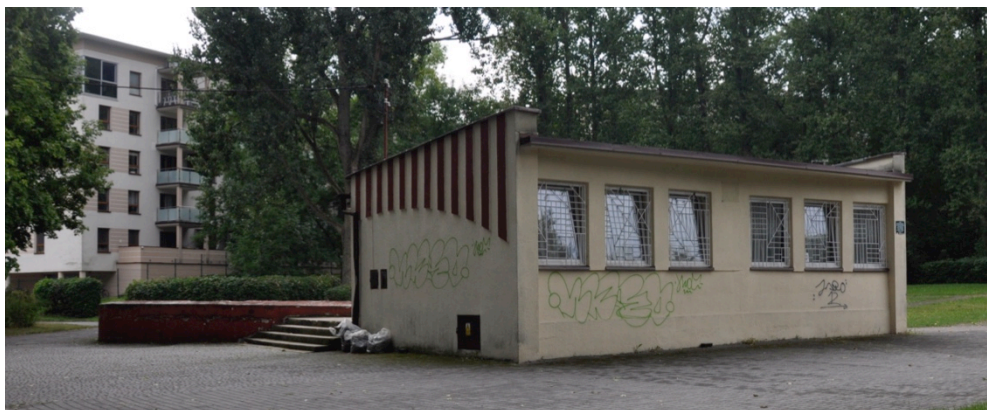
Ryc. 66: budynek zaplecza dawnej sceny plenerowej, w tle widoczny budynek mieszkalny na miejscu browaru / fotografia ACAKA 2022
