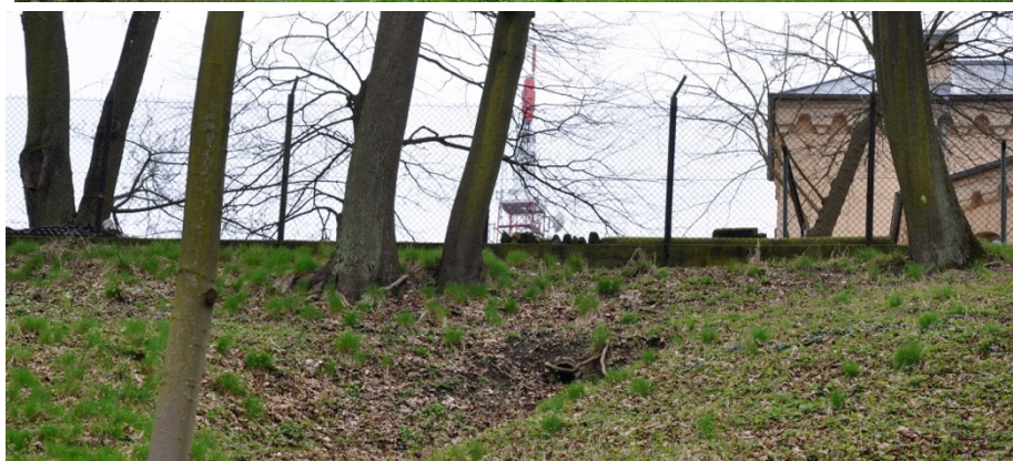
Ryc. 49: przewód odprowadzający wodę opadową z dachów budynków zespołu pałacowego oraz bezpośredniego otoczenia pałacu / fotografia ACAKA 2022
