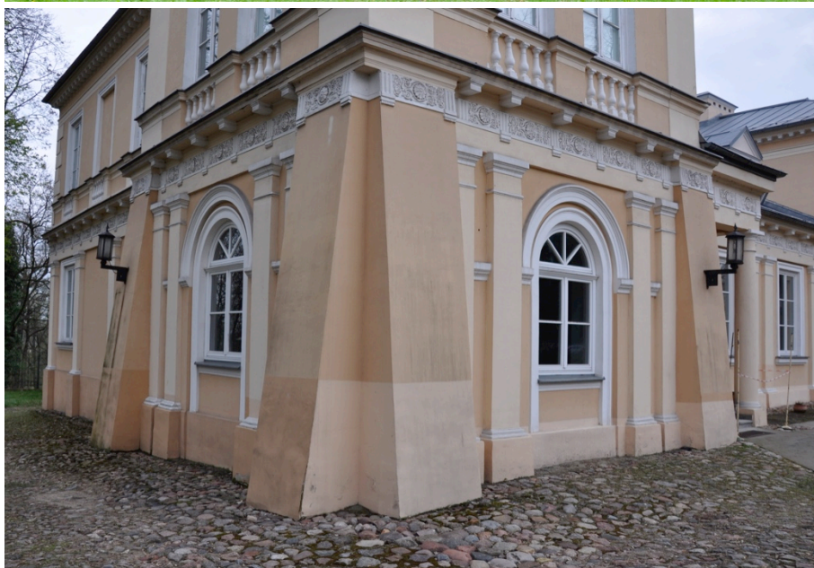
Ryc. 84: oprawy oświetleniowe zamontowane na elewacji budynku pałacu - muzeum / fotografia ACAKA 2023
