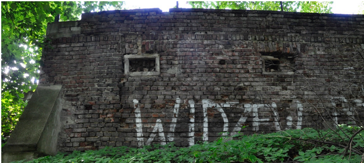
Ryc. 85: relikty murów dawnego budynku gospodarczego na krawędzi skarpy Widoczna destrukcja lica muru poprzez napór gruntu nasypowego zgromadzonego wewnątrz (dawne okna piwnicy), oraz stan cegieł wraz z wtórnymi wątkami nadbudowy korony muru. / fotografia ACAKA 2023.
