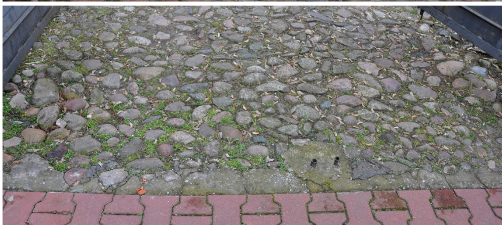
Ryc. 96: bruk kamienny w miejscu połączenia z wjazdem z ulicy POW / stan 2023, widoczny wtórny chodnik (wylewka betonowa) dojścia do budynku pałacu
