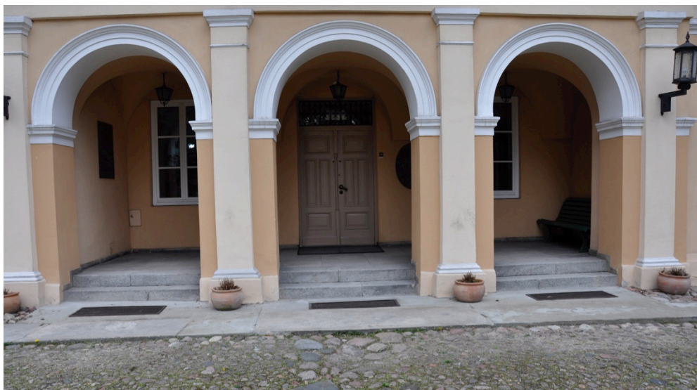
Ryc. 93: schody główne wejściowe do Muzeum – dojście wykonane z wylewanego betonu należy zastąpić płytą kamienną / fotografia ACAKA 2023
