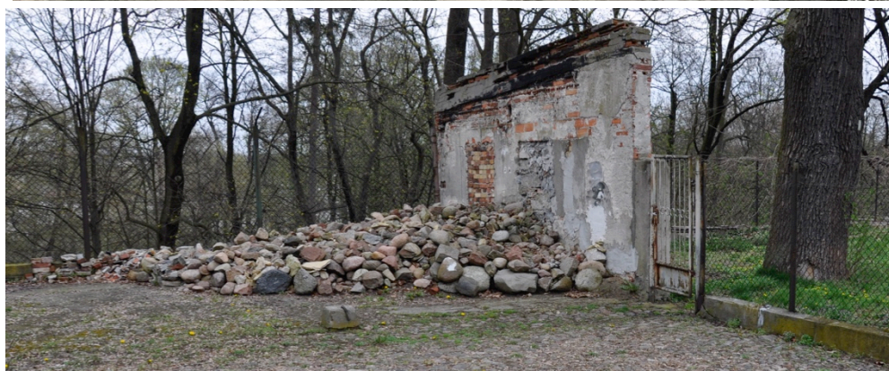
Ryc. 62: fragment reliktów murów zabudowań części gospodarczej oraz elementy kamienne i gruz zgromadzony przy krawędzi skarpy / fotografia ACAKA 2022
