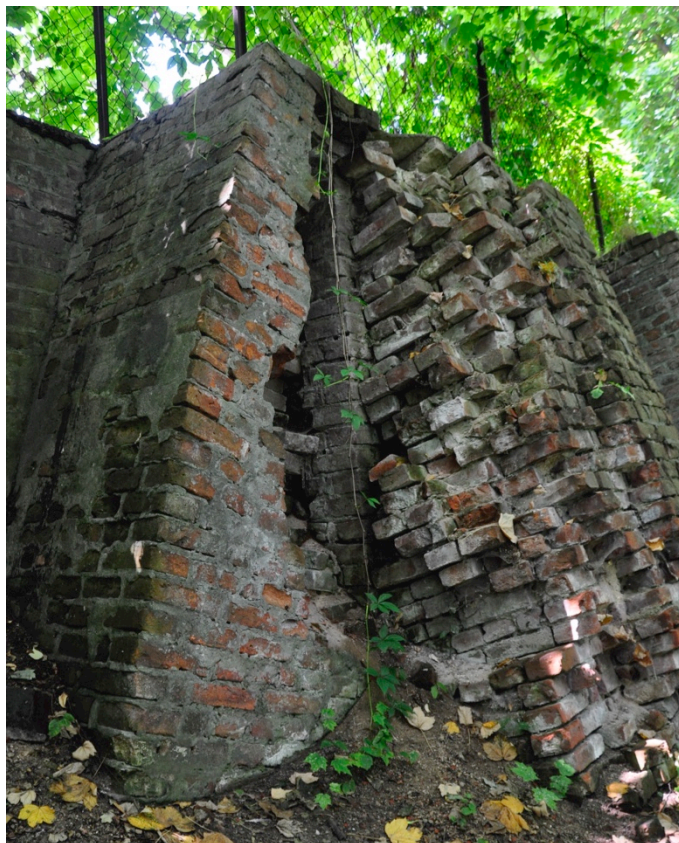
Ryc. 88: Relikty muru; widoczne znaczne uszkodzenia (zawilgocenie, zasolenie oraz znaczne ubytki struktury) narożnika muru oraz przypór – dostawionych wtórnie (widoczny brak powiązania muru oraz inny rodzaj użytej cegły); / fotografia ACAKA 2023
