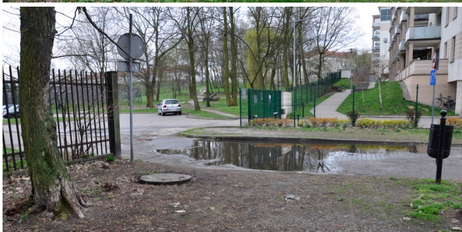
Ryc. 47: wejście i wjazd na teren parku od strony ul. Ligii Morskiej i Rzecznej – ciąg pieszo jezdny – widoczny problem z brakiem odprowadzenia nadmiaru wód opadowych / fotografia ACAKA 2022
