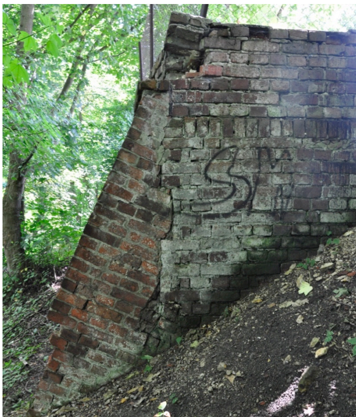
Ryc. 89: Relikty muru; na fotografii widoczny brak wiązania wstęgu ceglanego pomiędzy murem dawnej piwnicy a przyporą dostawioną najpewniej wtórnie ze względu na utratę nośności ściany. / fotografia ACAKA 2023
