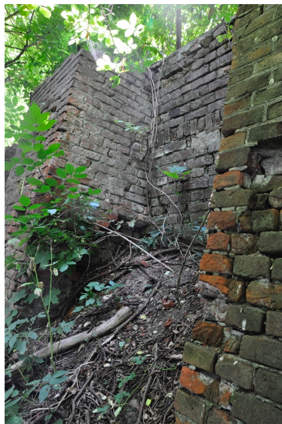
Ryc. 89: Relikty muru; na fotografii widoczny brak wiązania wstęgu ceglanego pomiędzy murem dawnej piwnicy a przyporą dostawioną najpewniej wtórnie ze względu na utratę nośności ściany. / fotografia ACAKA 2023
