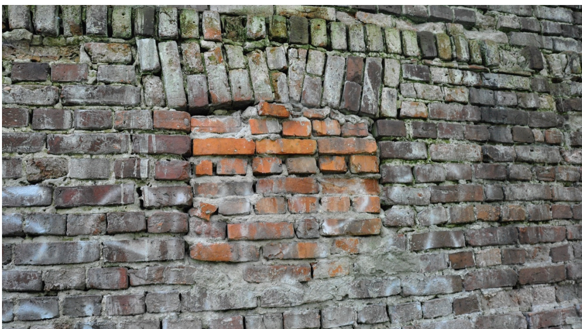
Ryc. 87: relikty murów dawnego budynku gospodarczego na krawędzi skarpy Widoczna destrukcja lica muru oraz wtórne przemurowania. / fotografia ACAKA 2023.
