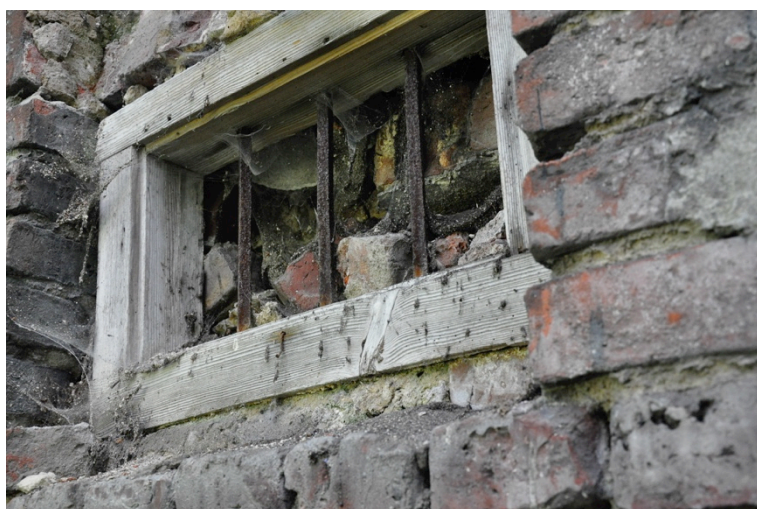
Ryc. 85: relikty murów dawnego budynku gospodarczego na krawędzi skarpy Widoczna destrukcja lica muru poprzez napór gruntu nasypowego zgromadzonego wewnątrz (dawne okna piwnicy), oraz stan cegieł wraz z wtórnymi wątkami nadbudowy korony muru. / fotografia ACAKA 2023.
