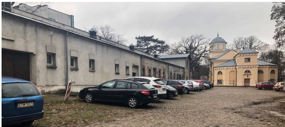
Ryc. 57: budynek dawnej stajni i wozowni oraz podwórze gospodarcze – aktualnie wykorzystywane jako parking / fotografia ACAKA 2022
