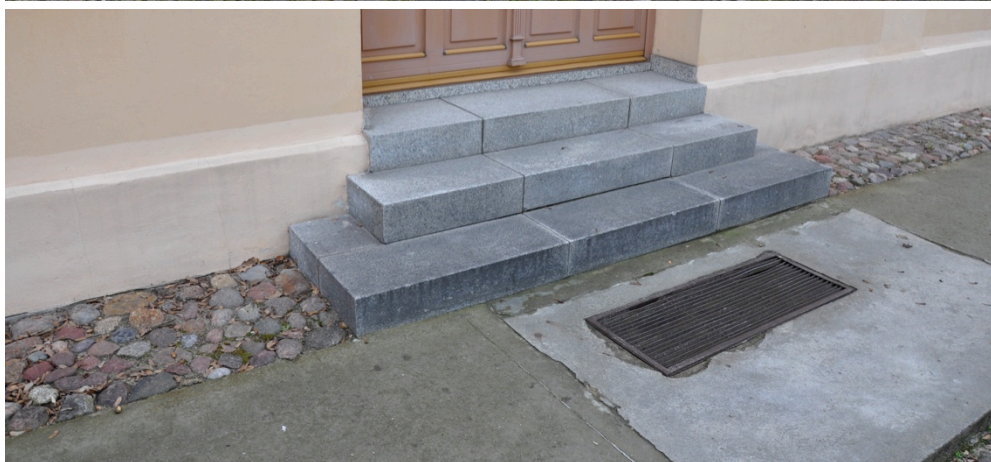
Ryc. 94: schody wejściowe do Muzeum przewidziane do pozostawienia / bruk kamienny i wylewka betonowa przewidziana do zastąpienia płytą kamienną / fotografia ACAKA 2023
