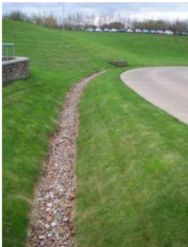
Rys. 7 Rów infiltracyjny wypełniony żwirem - zdjęcie poglądowe
