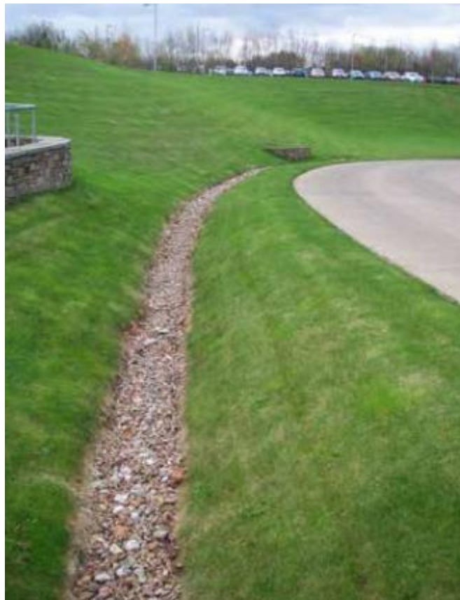
Rys. 7 Rów infiltracyjny wypełniony żwirem - zdjęcie pogładowe
