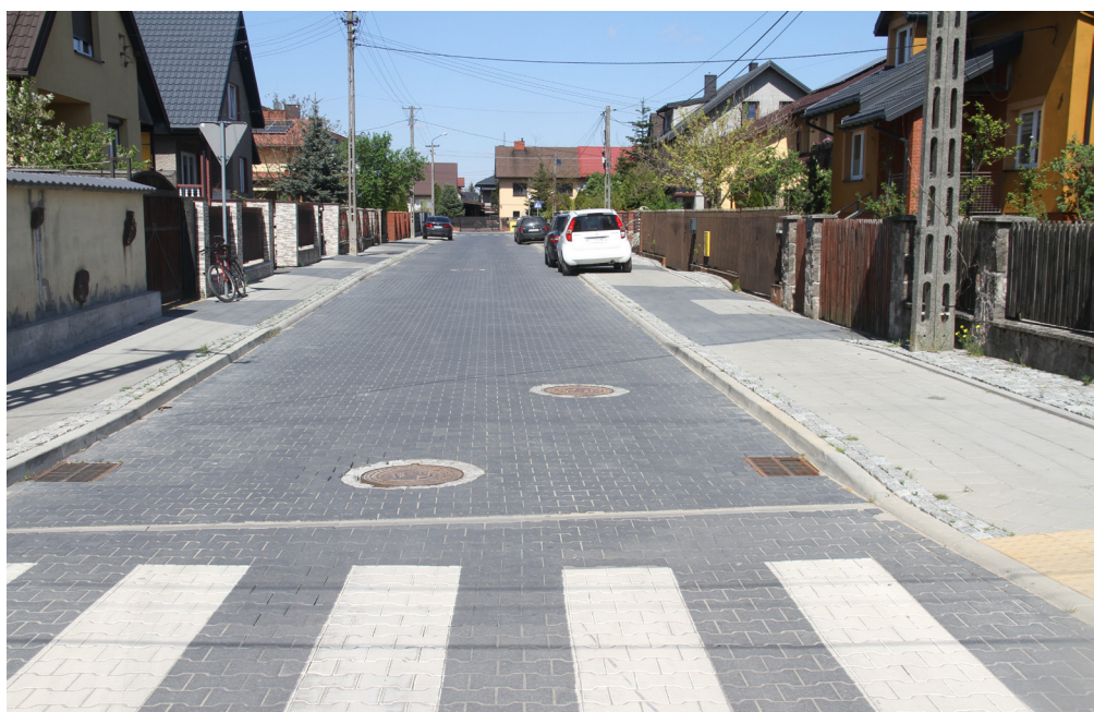
Przebudowana ulica Ignacego w Tomaszowie Mazowieckim
