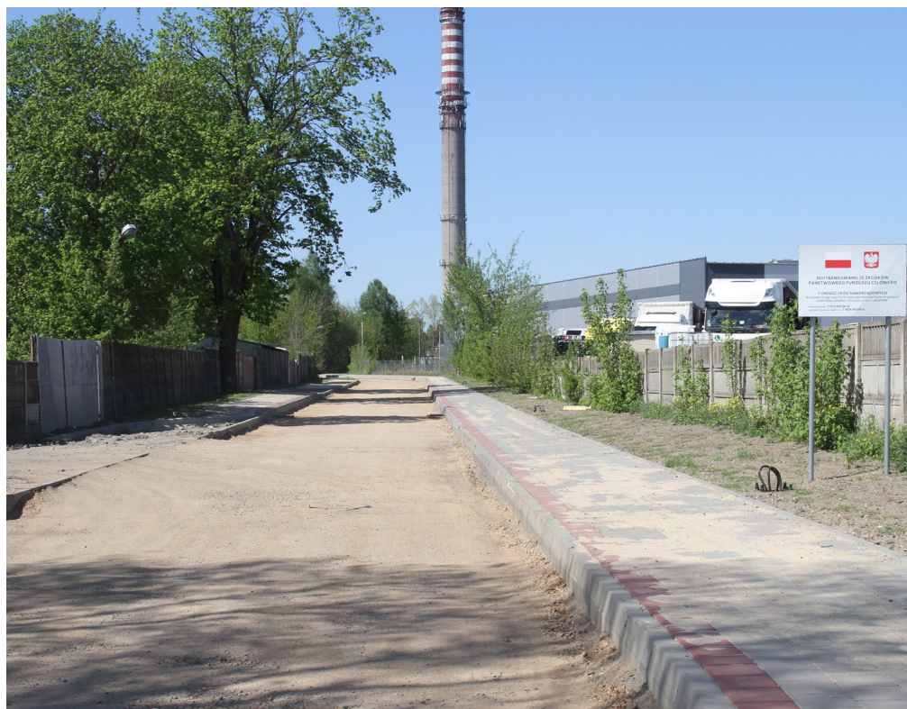
Miasto pozyskało ponad 3,5 mln zł dofinansowania na budowę drogi na terenie byłego „Wistomu”
