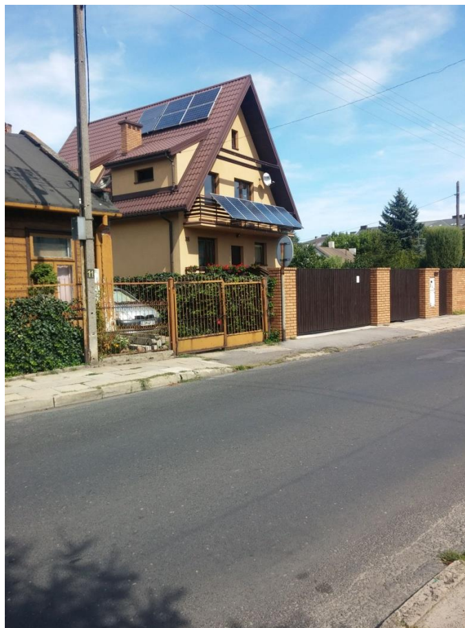
Fot. 3-3 Ogniwa fotowoltaiczne na ulicy Smugowej
