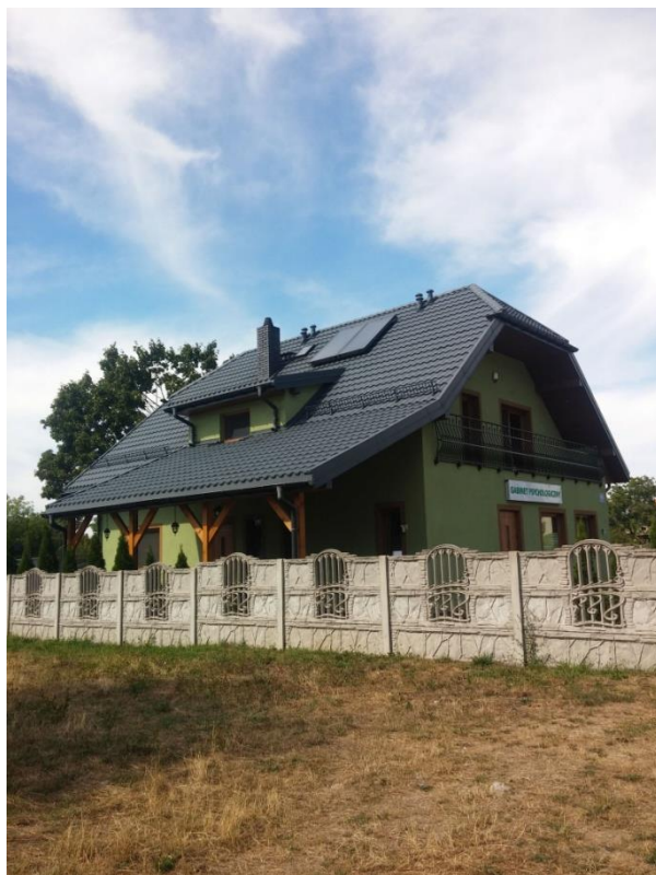
Fot. 3-2 Kolektory słoneczne na ulicy Lewej
