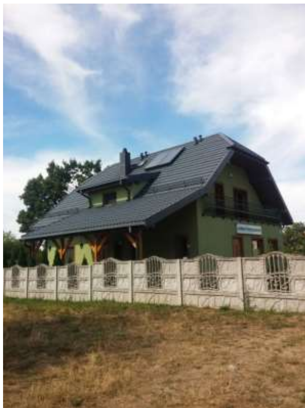
Fot. 3-2 Kolektory słoneczne na ulicy Lewej
