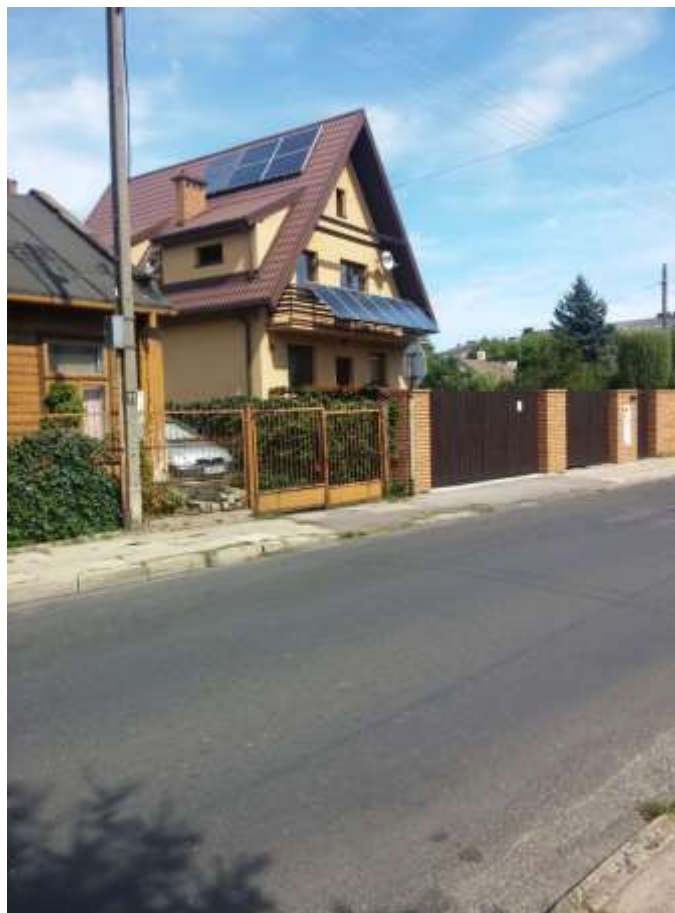
Fot. 3-3 Ogniwa fotowoltaiczne na ulicy Smugowej
