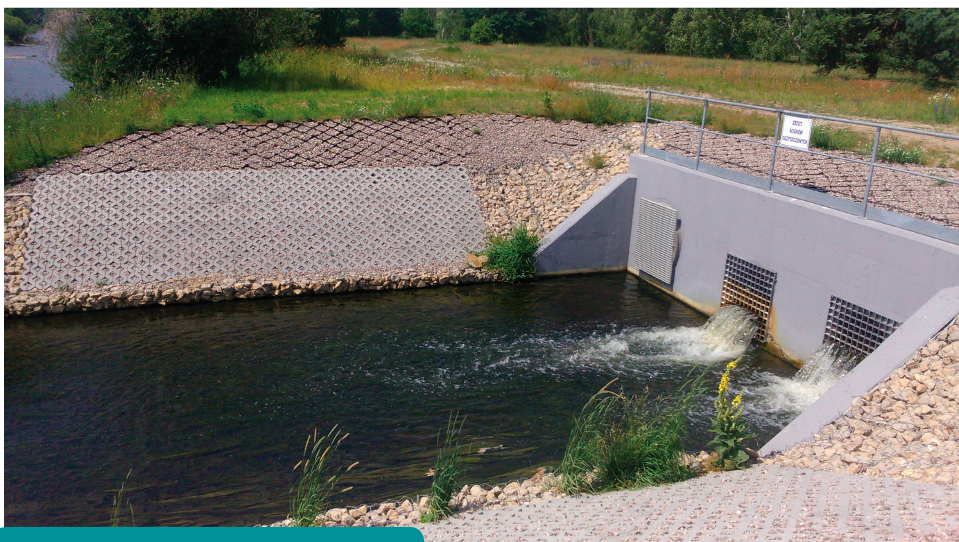
Fot. 2.4 Wylot ścieków do rzeki Pilicy z miejskiej oczyszczalni w Tomaszowie Mazowieckim
