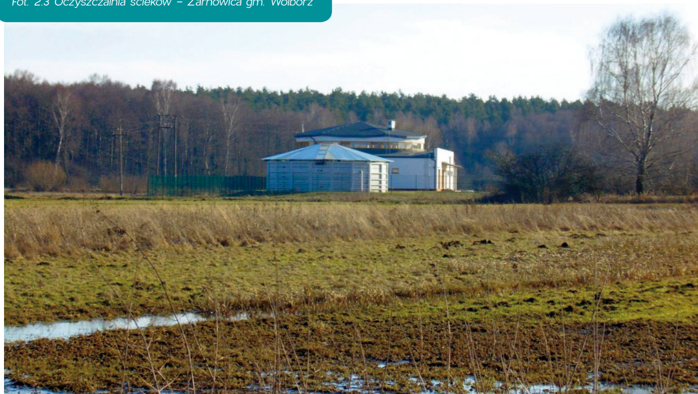
Fot. 2.3 Oczyszczalnia ścieków – Żarnowica gm. Wolbórz
