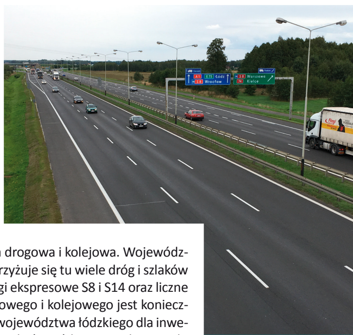
Fot. 2.5 Autostrada A1 (widok z wiaduktu w Piotrkowie Trybunalskim)
