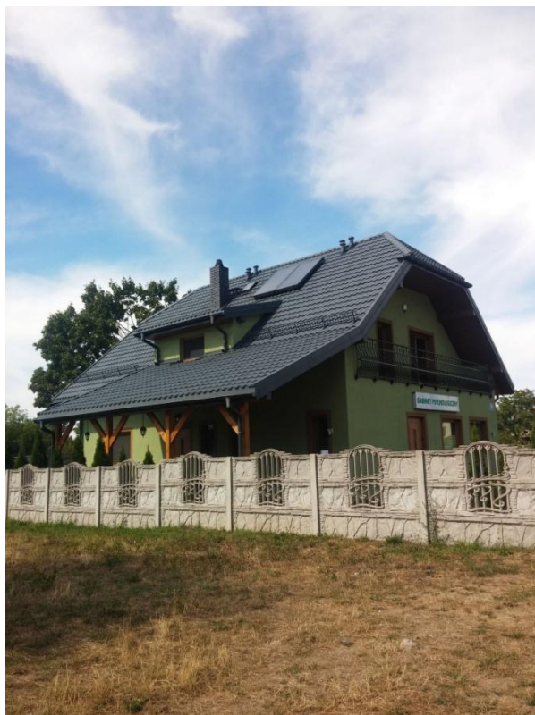
Fot. 3-2 Kolektory słoneczne na ulicy Lewej
