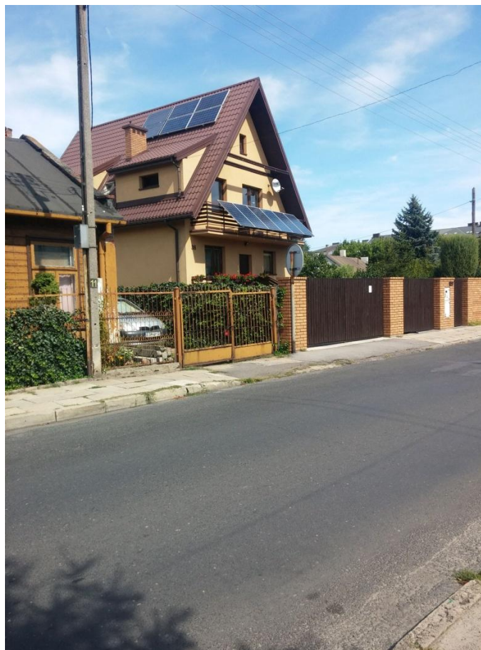
Fot. 3-3 Ogniwa fotowoltaiczne na ulicy Smugowej
