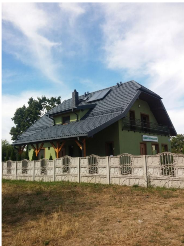
Fot. 3-2 Kolektory słoneczne na ulicy Lewej
