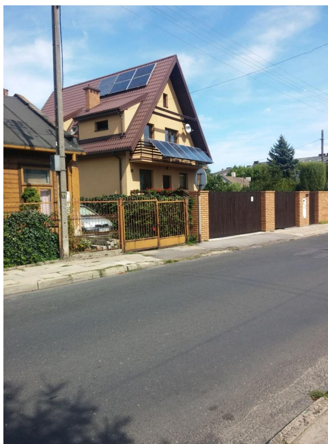
Fot. 3-3 Ogniwa fotowoltaiczne na ulicy Smugowej
