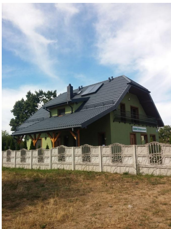
Fot. 3-2 Kolektory słoneczne na ulicy Lewej
