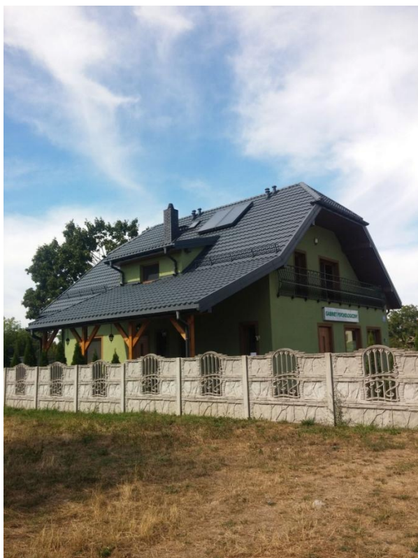
Fot. 3-2 Kolektory słoneczne na ulicy Lewej
